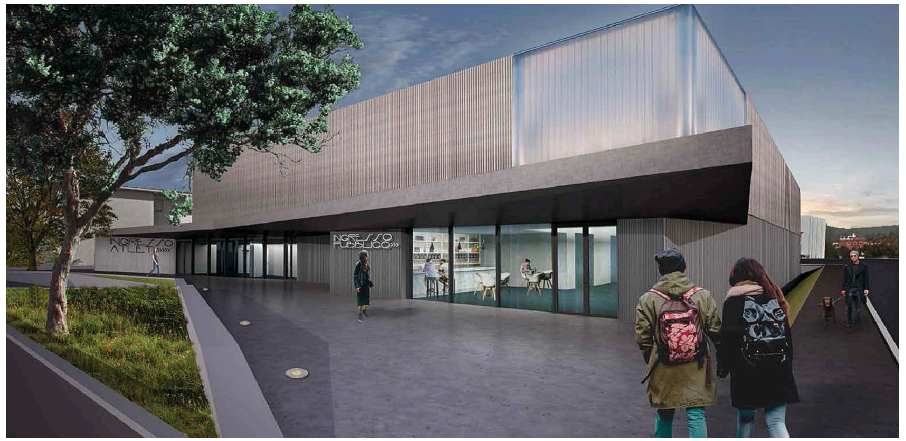
Progetto della nuova palestra in costruzione in via S. Gaetano
