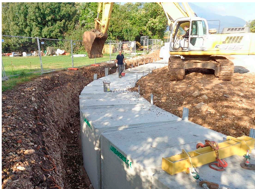
La posa degli scatolari del canale scolmatore è stata una fase particolarmente delicata per la presenza di numerosi sottoservizi e della linea aerea di alta tensione
