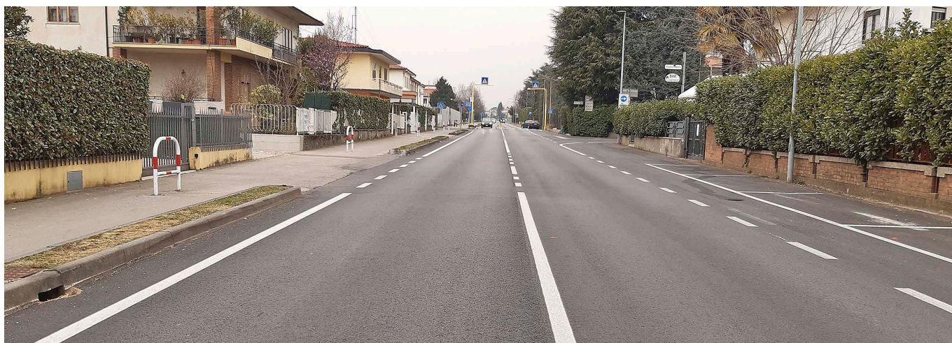
Via Lavarone dopo i lavori di asfaltatura
