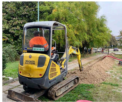
Lavori di sistemazione dell'impianto elettrico al Parco degli Alpini a Caselle
