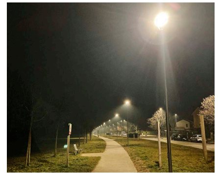
Lavori di illuminazione pubblica a San Domenico: nuovo tratto di illuminazione del percorso vita in via Vespucci. Nuovi lampioni e punti luce in via C. Colombo, in via Cadamosto e nel parcheggio di via San Matteo
