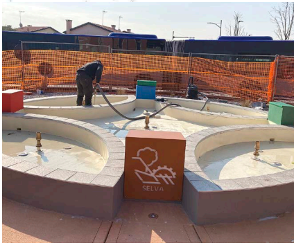
Realizzazione della fontana nella rotonda di Caselle
