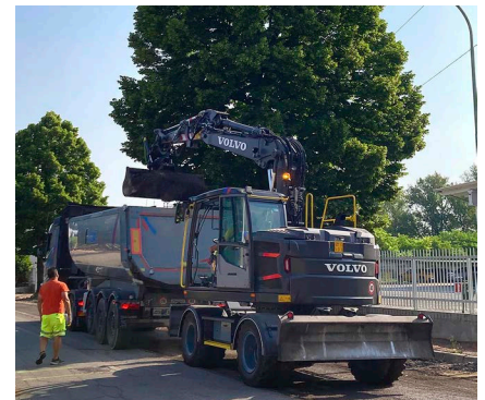
Asfaltatura in via Volta a Caselle
