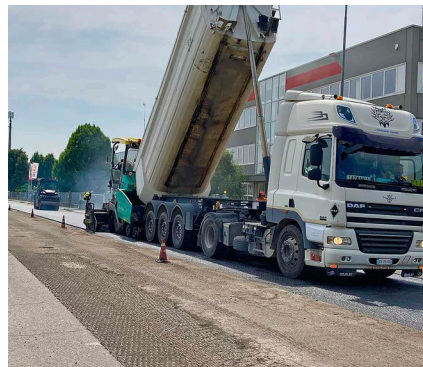
Asfaltatura in via Galvani a Caselle
