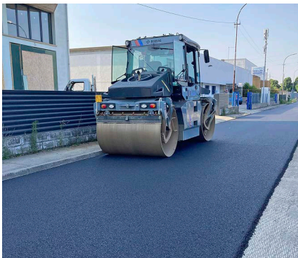
Asfaltatura in via Marconi a Caselle
