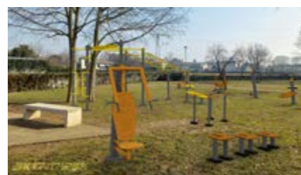
Fotoinserimento area fitness in realizzazione
