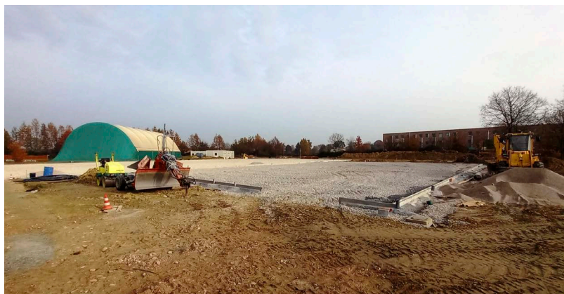
Inizio lavori. Fondamenta e pilastri
